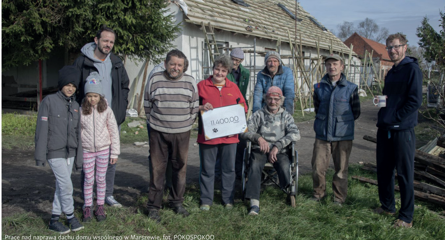
Prace nad naprawą dachu domu wspólnego w Marszewie, fot. POKOSPOKOO
